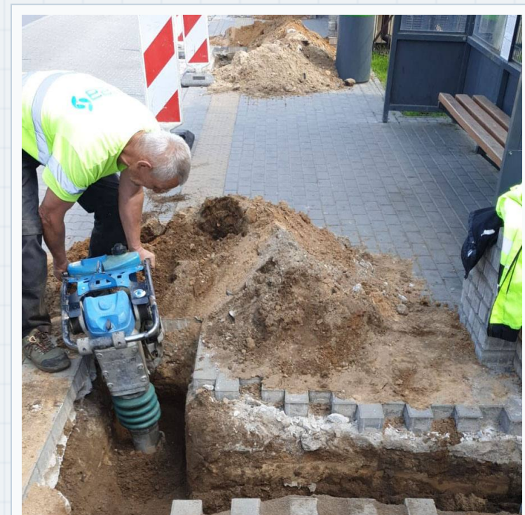
ODTWORZENIE NAWIERZCHNI PO BUDOWIE KANALIZACJI
