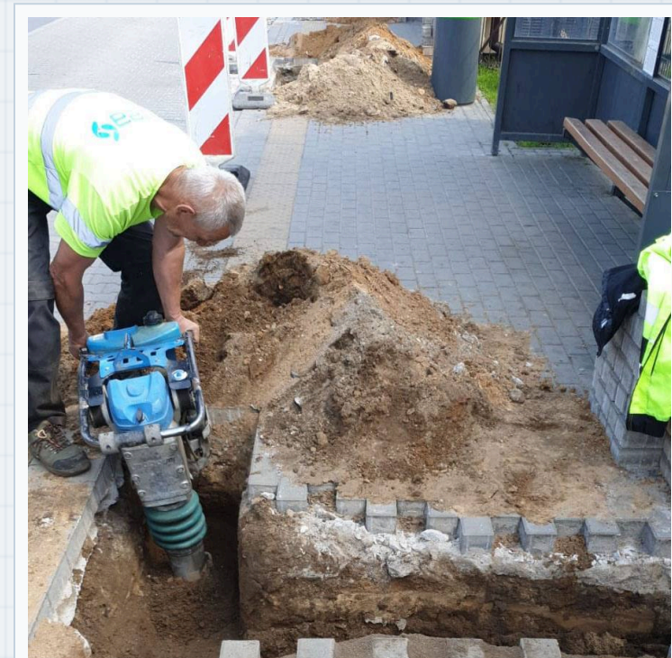
WIEDERHERSTELLUNG DER OBERFLÄCHE NACH DEM ROHRBAU
